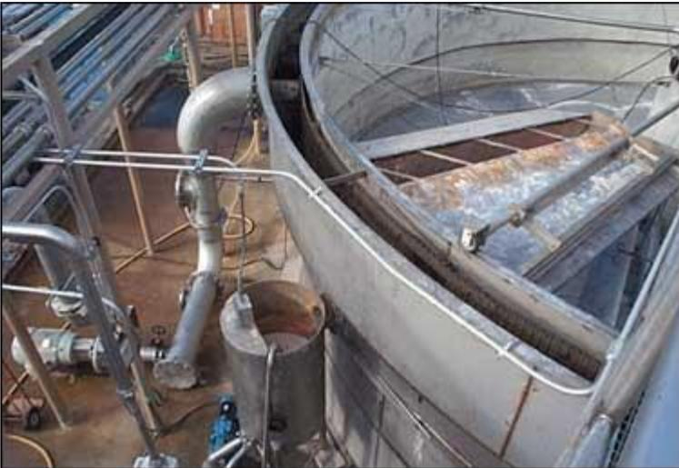
**Effluent Weir & Floating Sludge Hopper**
